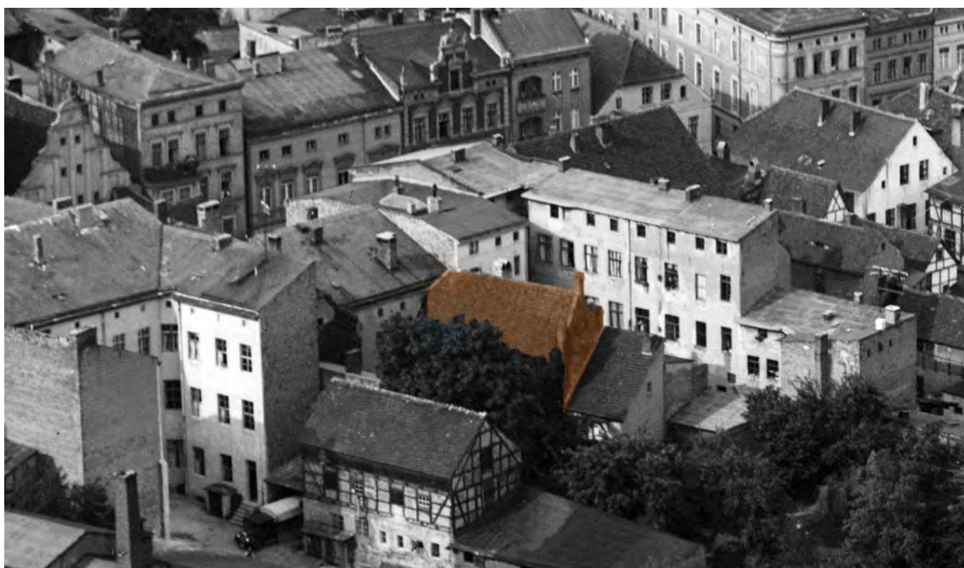
Ryc. 38. Stargard, Stare Miasto, kwartał IX. Późnośredniowieczny murowany budynek zaplecza działki (podbarwiony) przy współczesnej ul. Mieszka I (dawniej Pyritzerstrasse 11). Widok od SW. Fragment fotografii lotniczej z ok. 1930 r. Ze zbiorów Herder-Institut w Marburgu, sygn. 57743. Oprac. M. Majewski Abb. 38. Stargard, Altstadt, Quartier IX. Spätmittelalterliches Backsteingebäude im Hinterhof des Grundstücks (koloriert) in der ehemaligen Pyritzerstraße 11 (heute: ul. Mieszka I). Ansicht von Südwesten. Fragment eines Luftbildes von ca. 1930. Aus der Sammlung des Herder-Instituts in Marburg, Sign. 57743. Bearb. M. Majewski
