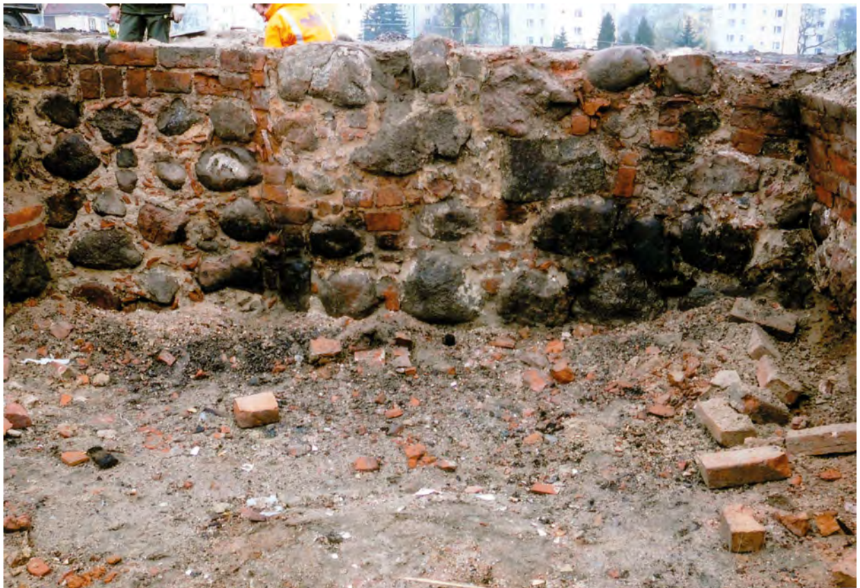
Ryc. 21. Stargard, Stare Miasto, kwartał IX. Ściana N piwnicy kamienicy Targ Drzewny 20. Widok od S. Fot. T. Balcerzak
