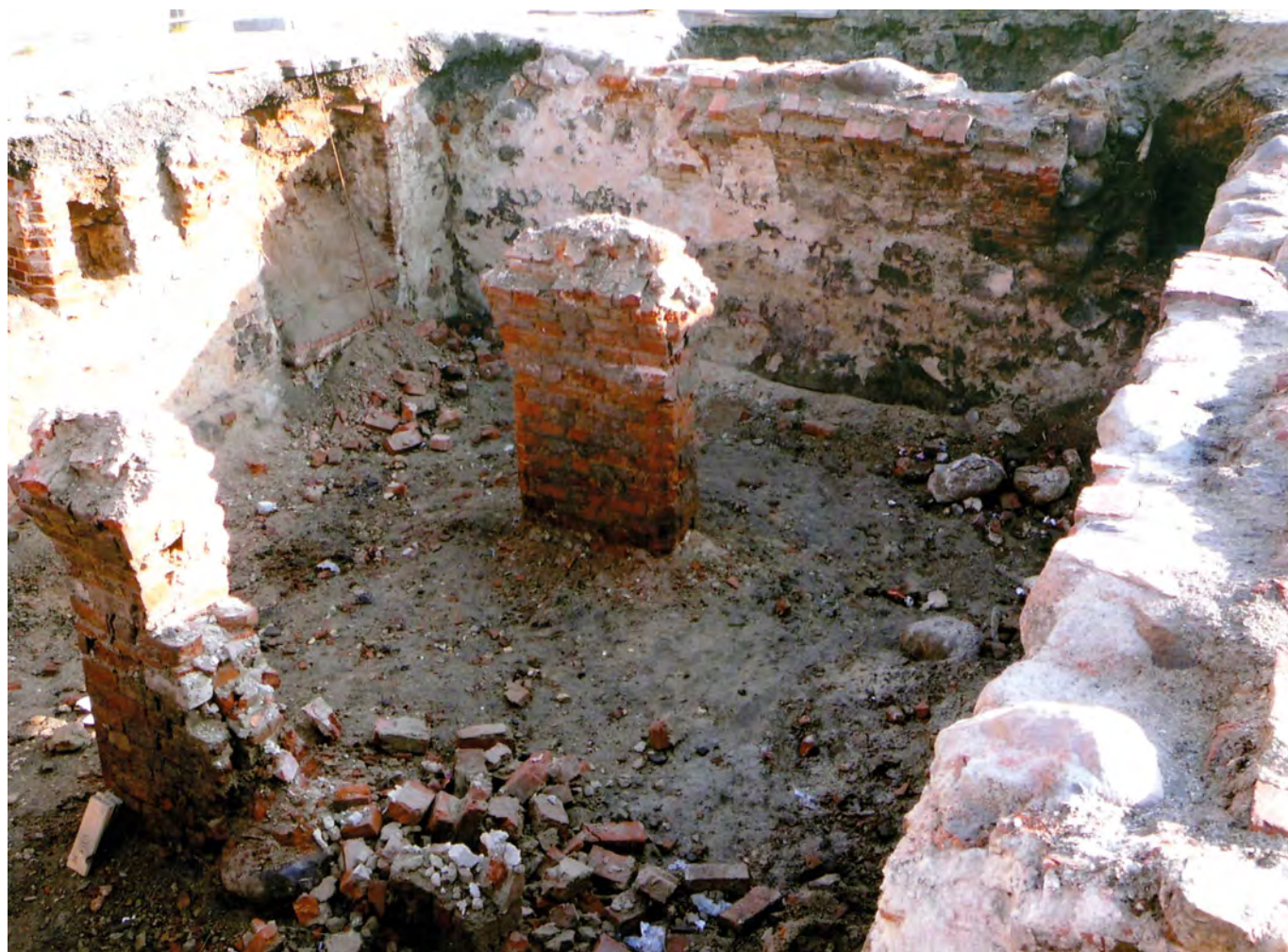
Ryc. 8. Stargard, Stare Miasto, kwartał IX. Wnętrze narożnej piwnicy kamienicy Targ Drzewny 19. Widok od NW. Fot. T. Balcerzak
