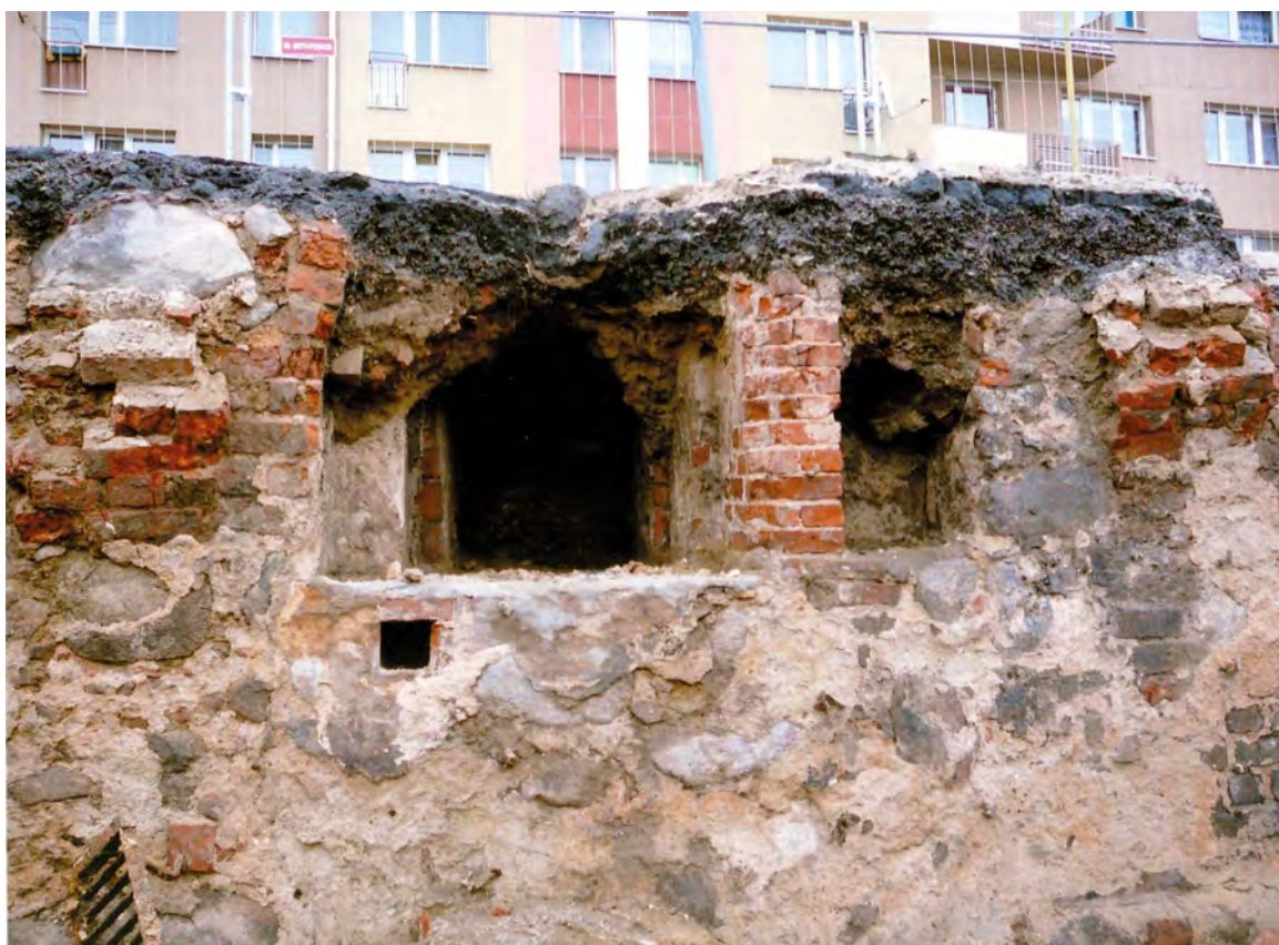
Ryc. 11. Stargard, Stare Miasto, kwartał IX. Ściana E narożnej piwnicy kamienicy Targ Drzewny 19 z niszami przekształconymi w otwory okienne. Fot. T. Balcerzak Abb. 11. Stargard, Altstadt, Quartier IX. Ostwand des Eckkellers des Bürgerhauses in der ehemaligen Holzmarktstraße 19 mit zu Fensteröffnungen umgebauten Nischen. Foto T. Balcerzak
