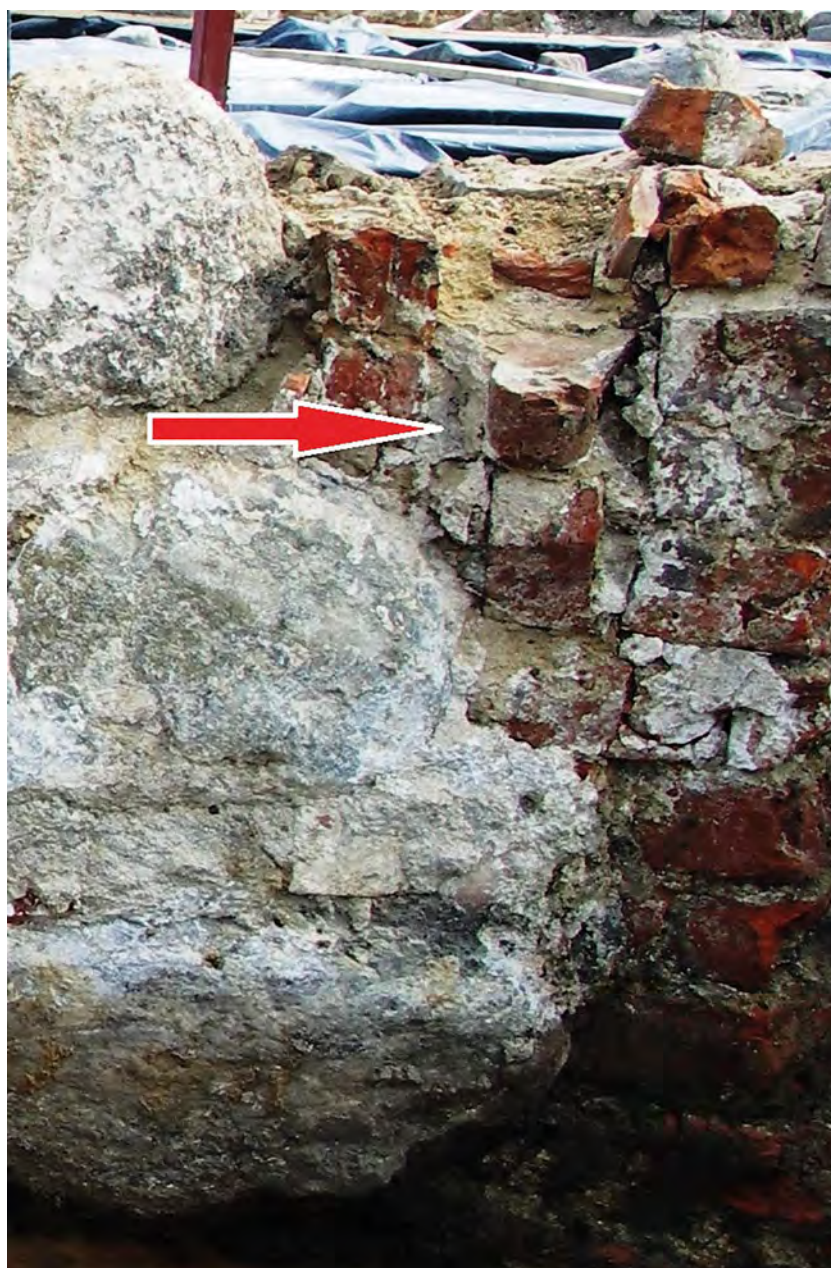
Ryc. 35. Stargard, Stare Miasto, kwartał IX. Konsola i relikty żebra w narożniku SE piwnicy na zapleczu parceli Targ Drzewny 21. Fot. K. Kwiatkowski
